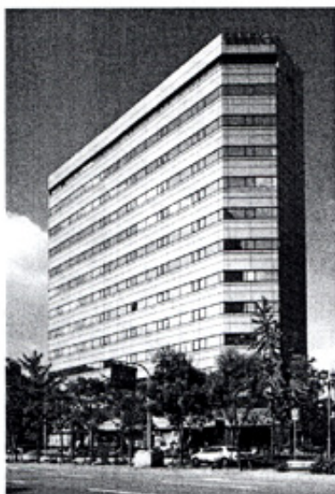
事務所がある南海野村ビル
